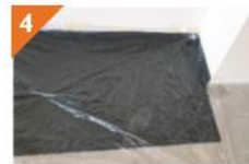
TUNEX HQ üzerine PE film serin. Birleşim noktalarını PVC bant ile sızdırmaz hale getirin.
