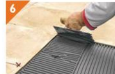
Zemin kaplamasını yapın.
