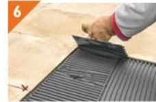
Zemin kaplamasını yapın.
