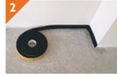
Duvar kenarlarına Akustik Bant yapıştırın.
